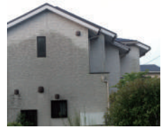
コーティングしていない壁面
